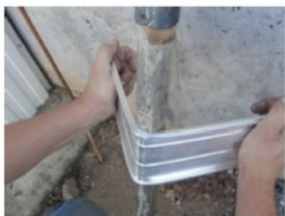
Façonnage d'un angle sur manche
