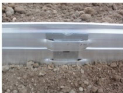
Pieu de fixation en position
